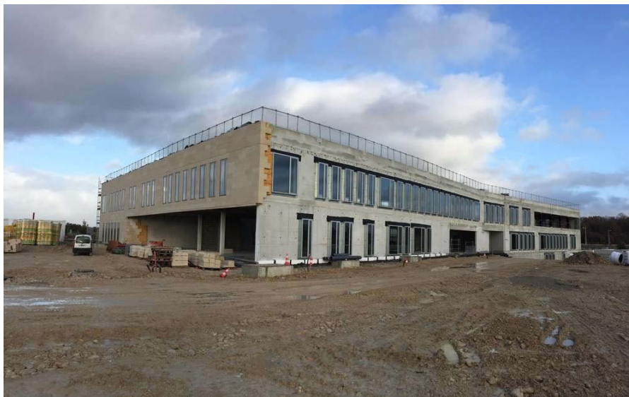
Les locaux de la MSA seront recouverts de parements en pierre de Sireuil.
