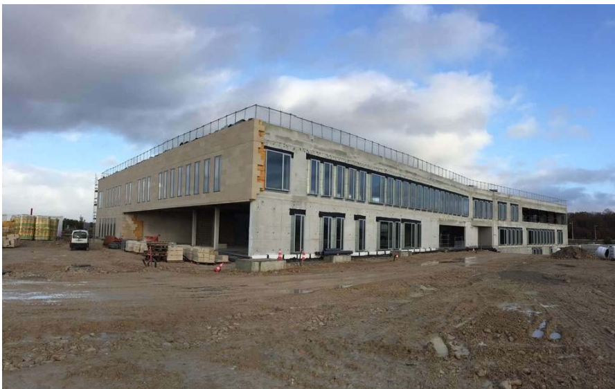
Les locaux de la MSA seront recouverts de parements en pierre de Sireuil.
